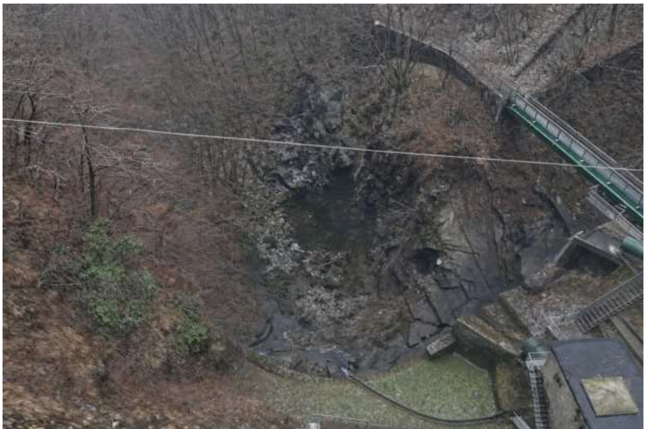
Figura 4-5: restituzione del DMV a valle della diga e condotta forzata
