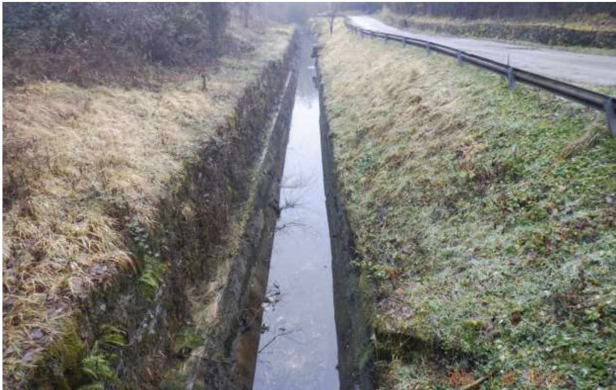
Figura 4-7: canale di scarico della centrale
