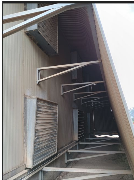
Vista interna cappe protezione estrattori
