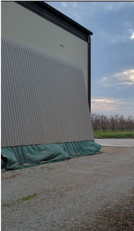
Vista esterna cappe protezione estrattori
