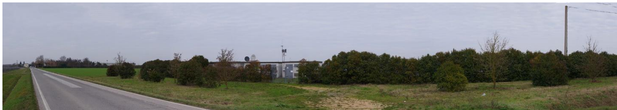
Figura 3-11 Impianto fotovoltaico (schermato) lungo via Puntiroli, a est di Conselice
