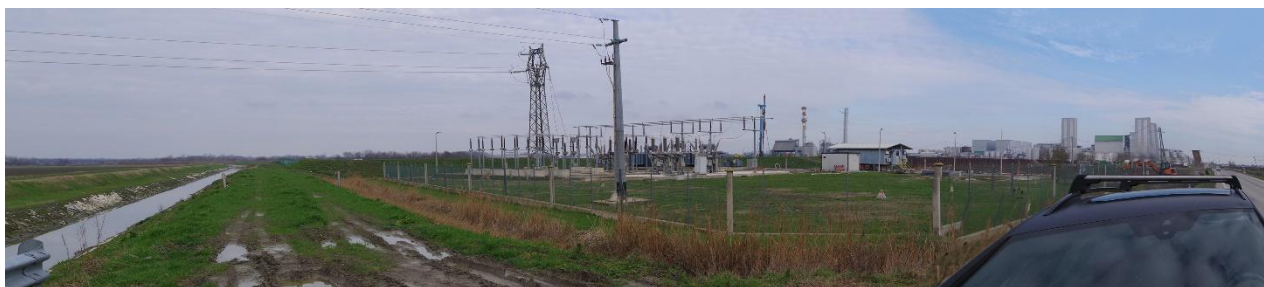
Figura 3-10 Stabilimento Unigrà e infrastrutture energetiche
