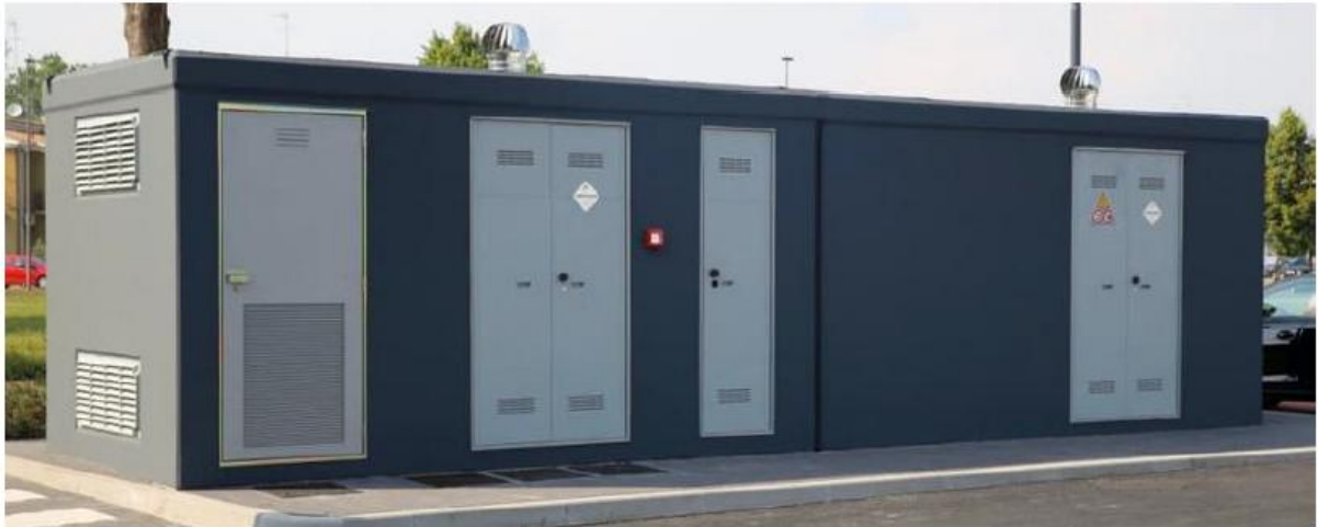
Figura 4-5 Tipologico cabine di smistamento
