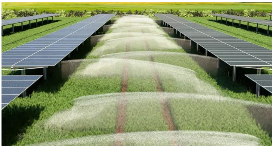
Figura 4-12 Esempio di sistema di irrigazione per micro-aspersione integrato sotto i moduli fotovoltaici.
