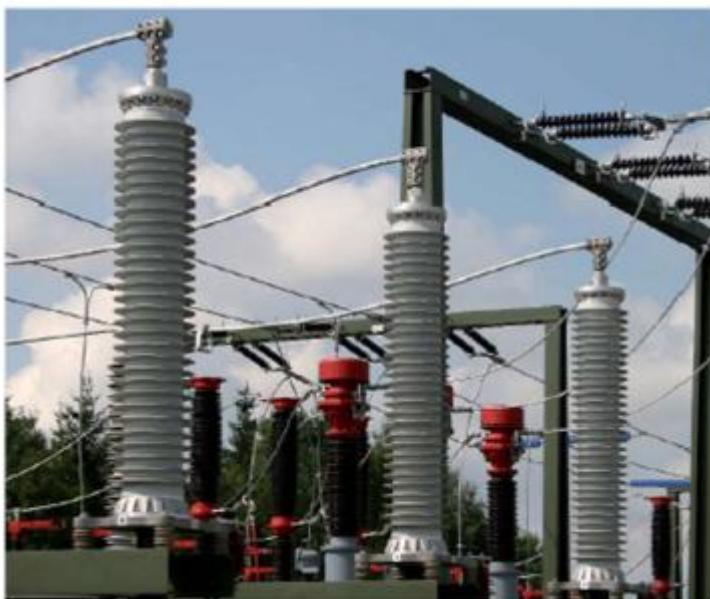
Figura 5.3: terminali di transizione conduttore rigido aereo-cavo XLPE progettati secondo le norme IEC-60840, IEC-60815, IEEE-48 e IEEE-1313
