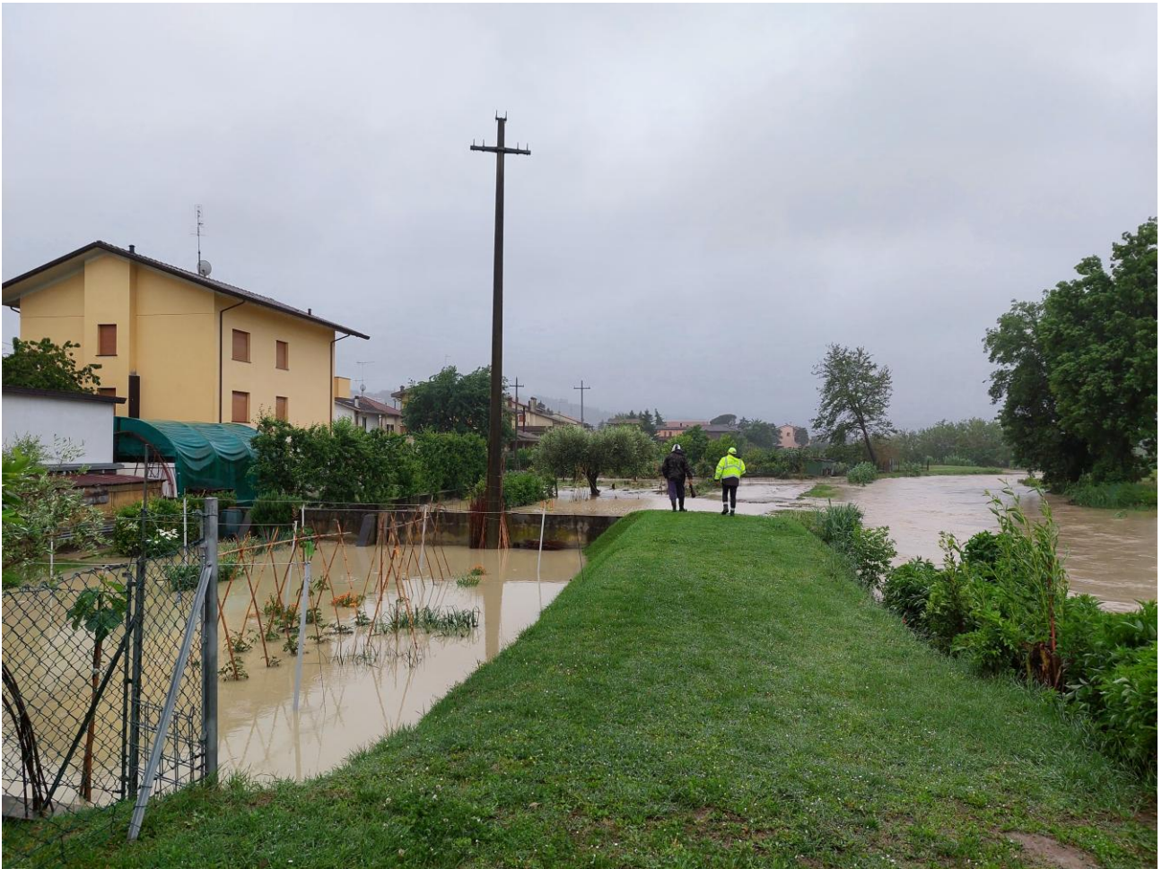
Figura 8 – Comune di Cesena, località Calisese, torrente Pisciatello, monte del ponte di Via Calisese, in destra idraulica, vista verso monte
