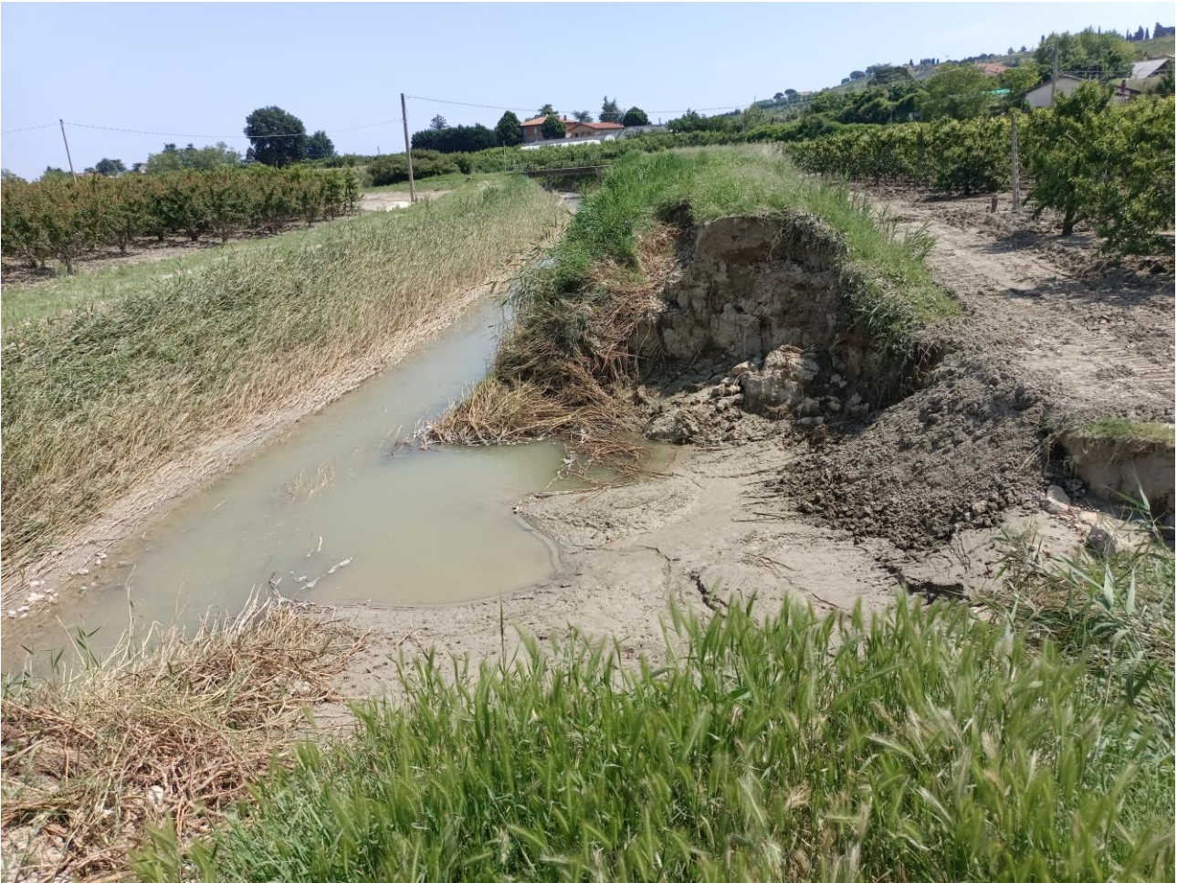
Figura 9 – Comune di Montiano, località Case Francisconi, torrente Pisciatello, monte del ponte di Via Tagliabraccio, vista verso valle
