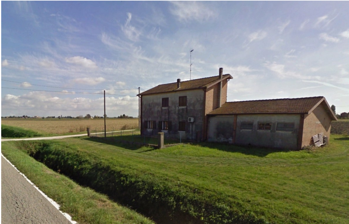
Figura 13-8: Casale adibito ad abitazione rurale
