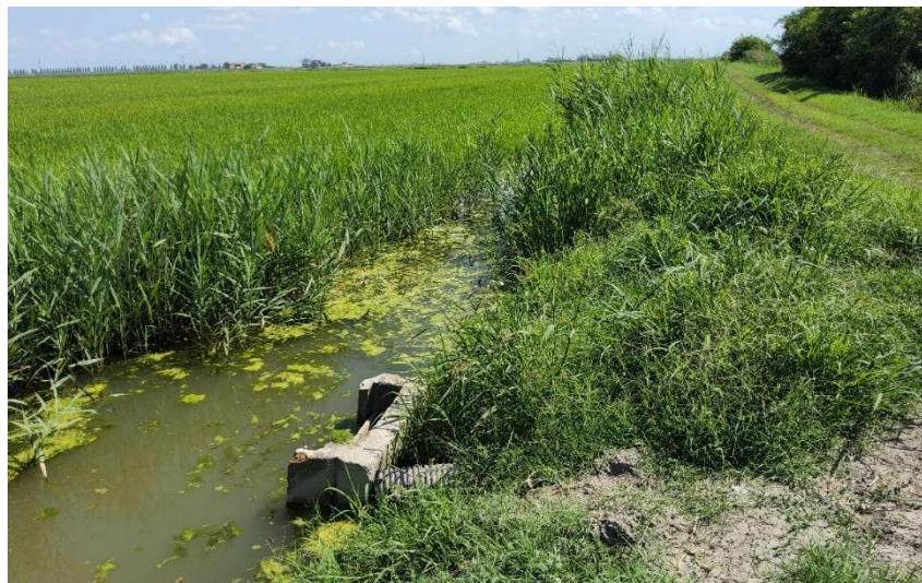
Figura 5. Manufatto di scarico settore 1
