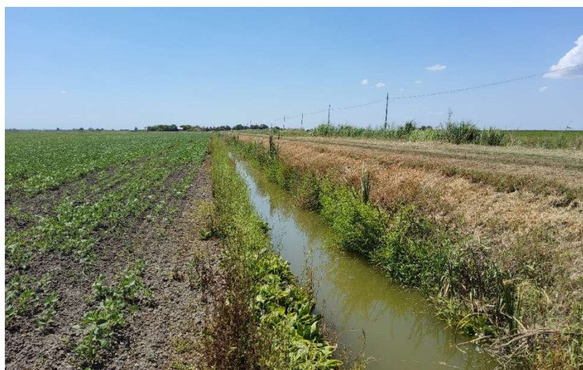
Figura 6. Canale di gronda settore 6
