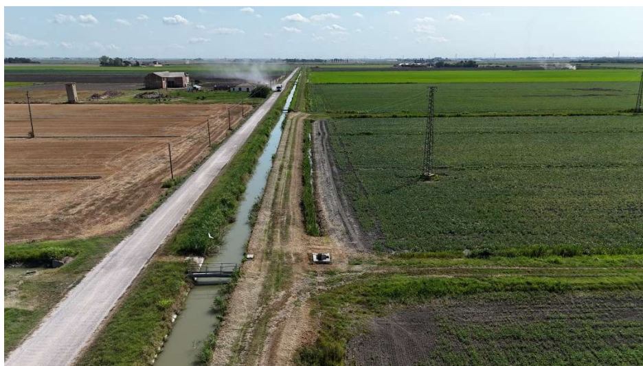
Figura 3. Collettore Lodigiana Nuovo e manufatto di carico settori 4, 5, 6 e 7
