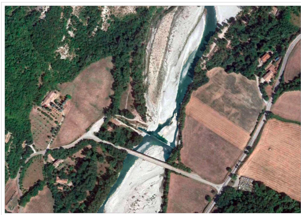
Figura 53 - Vista allo stato attuale
