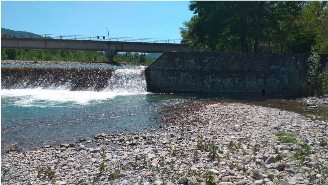
Figura 36 - Particolare briglia esistente, vista da valle (sinistra idraulica)
