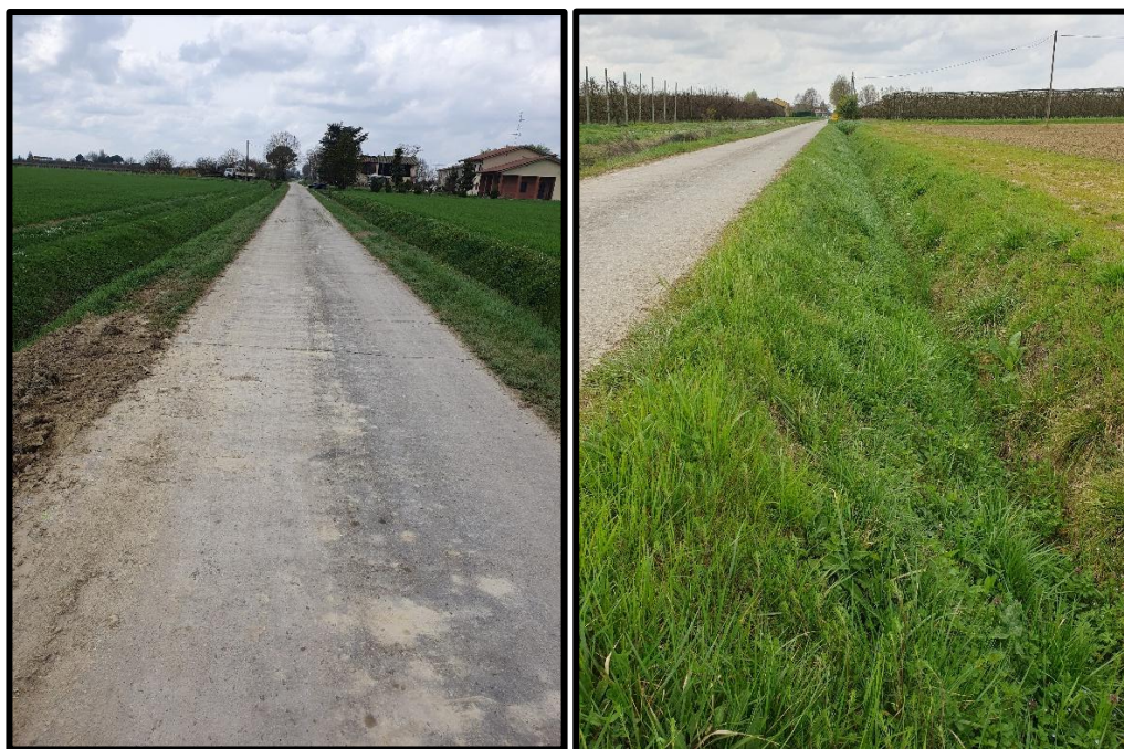
Figura 44: punti di presa 1-2, superficie stradale e banchina con canali di drenaggio.
