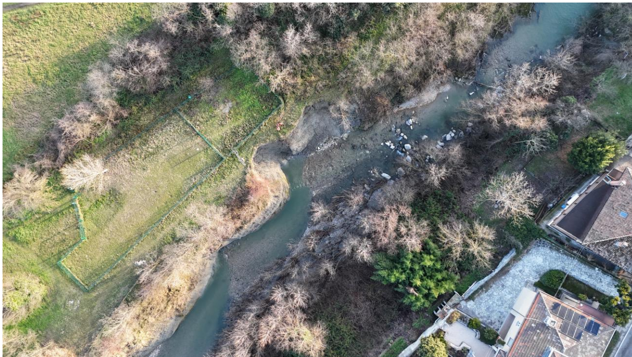
Vista dal drone di parte del tratto in oggetto con evidenza delle aree inerbite, porzioni franose e presenza di edifici adiacenti in sponda sinistra
