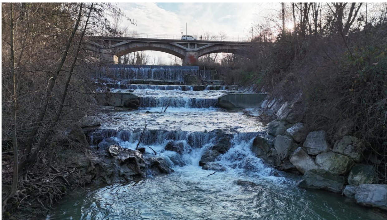
Vista dei risalti immediatamente a monte dell'area di intervento
