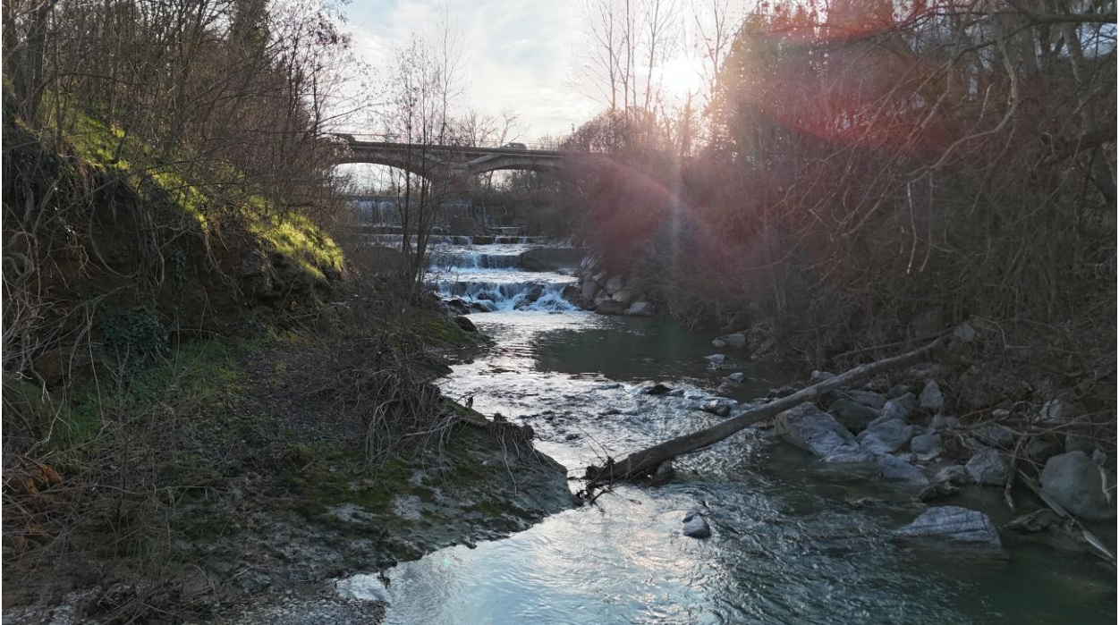
Vista da valle del tratto caratterizzato da avvallamento dell'alveo
