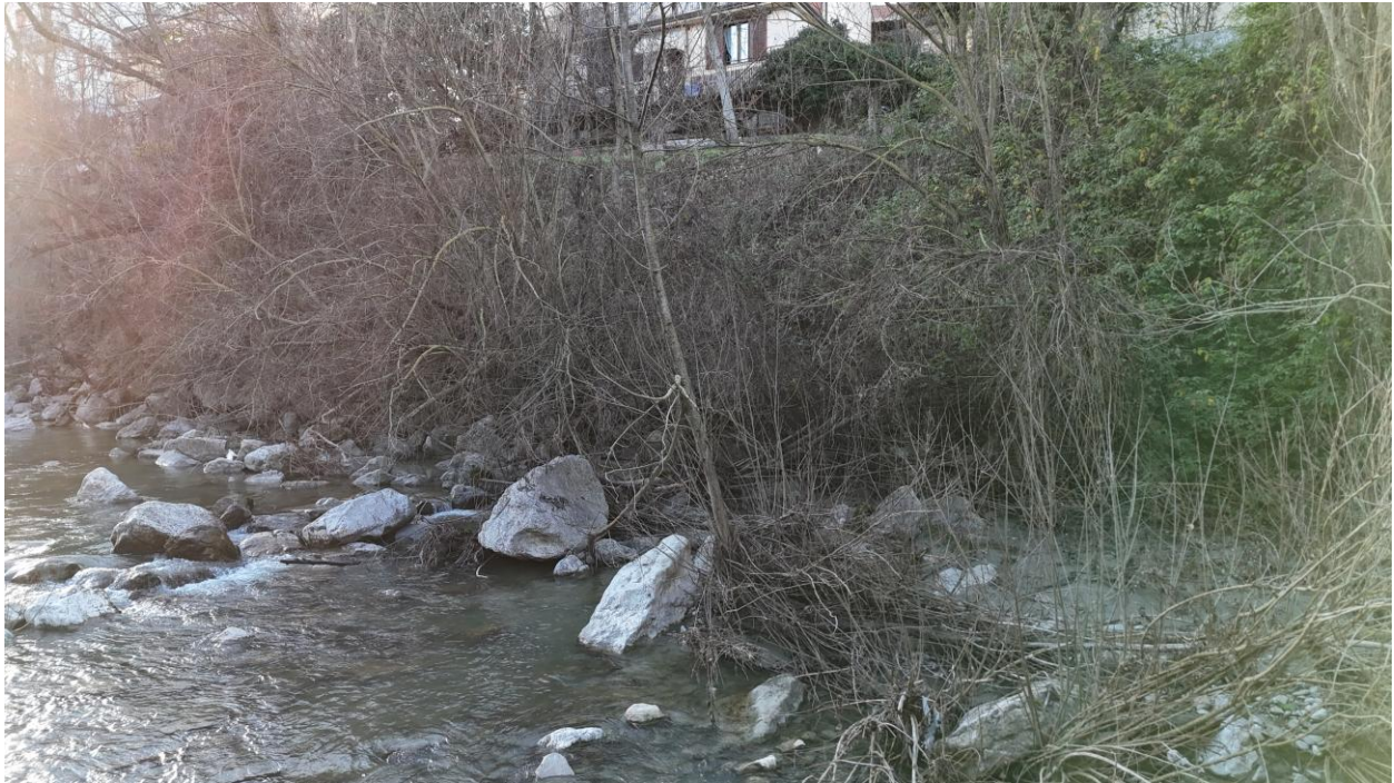
Vista della sponda destra immediatamente a valle dei risalti esistenti con evidenza della presenza di alcune edifici in adiacenza alla scarpata
