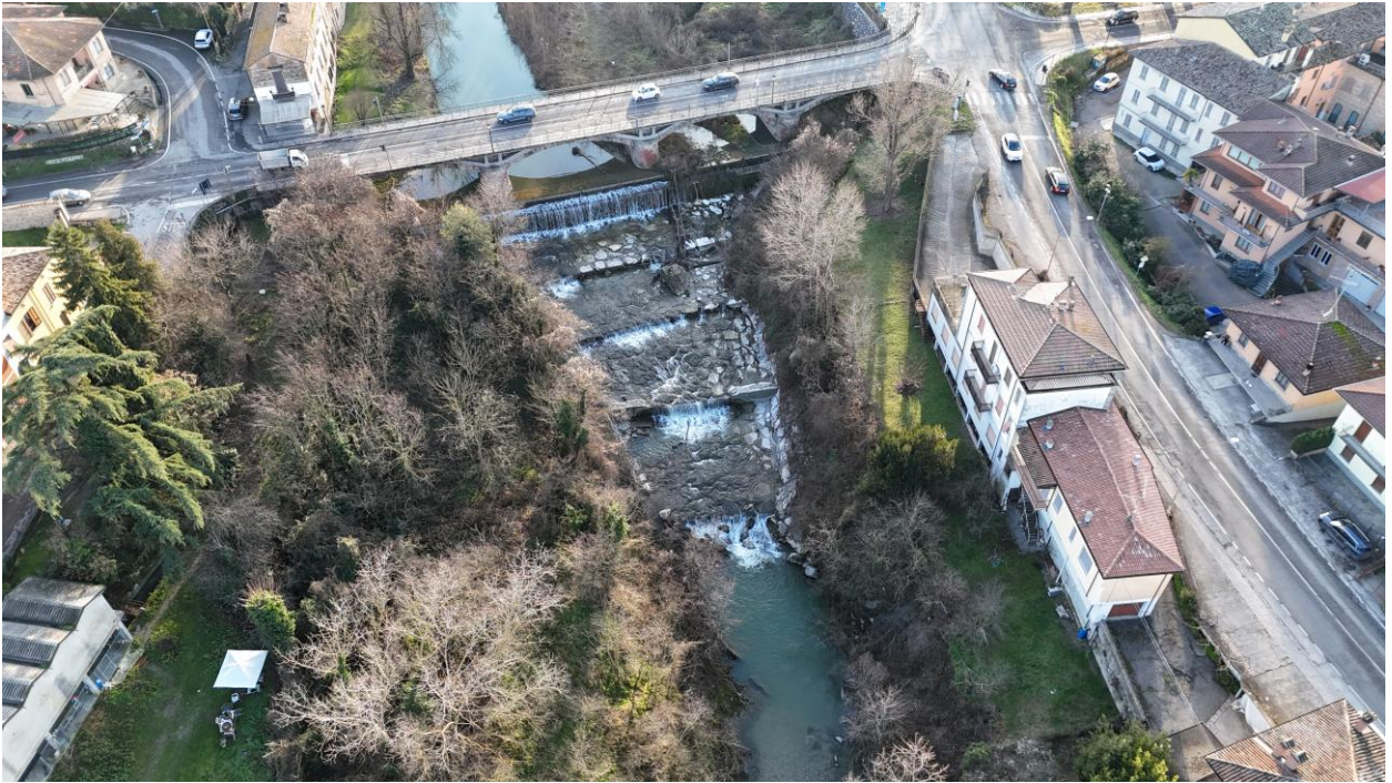
Vista aerea da drone del ponte e dei risalti di valle esistenti
