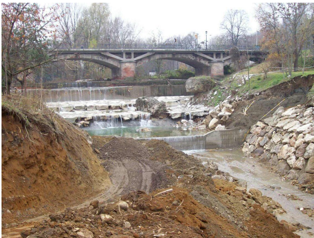
Figura 3 – Lavori sulla soglia del ponte della SP 4 – ripresa dalla sponda destra, da valle verso monte – (2007, Servizio Tecnico di Bacino)
