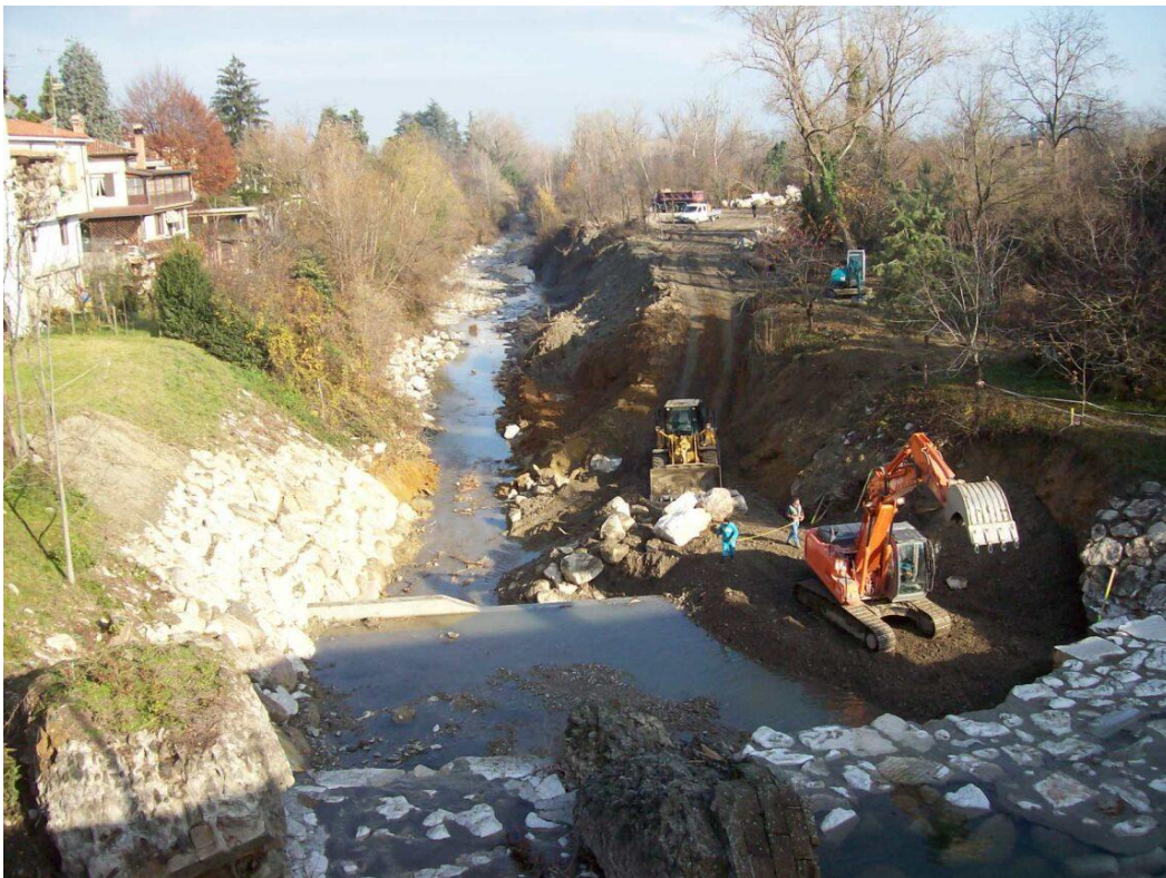
Figura 2 – Lavori sulla soglia del ponte della SP 4 – ripresa dal ponte, da monte verso valle – (2007, Servizio Tecnico di Bacino)
