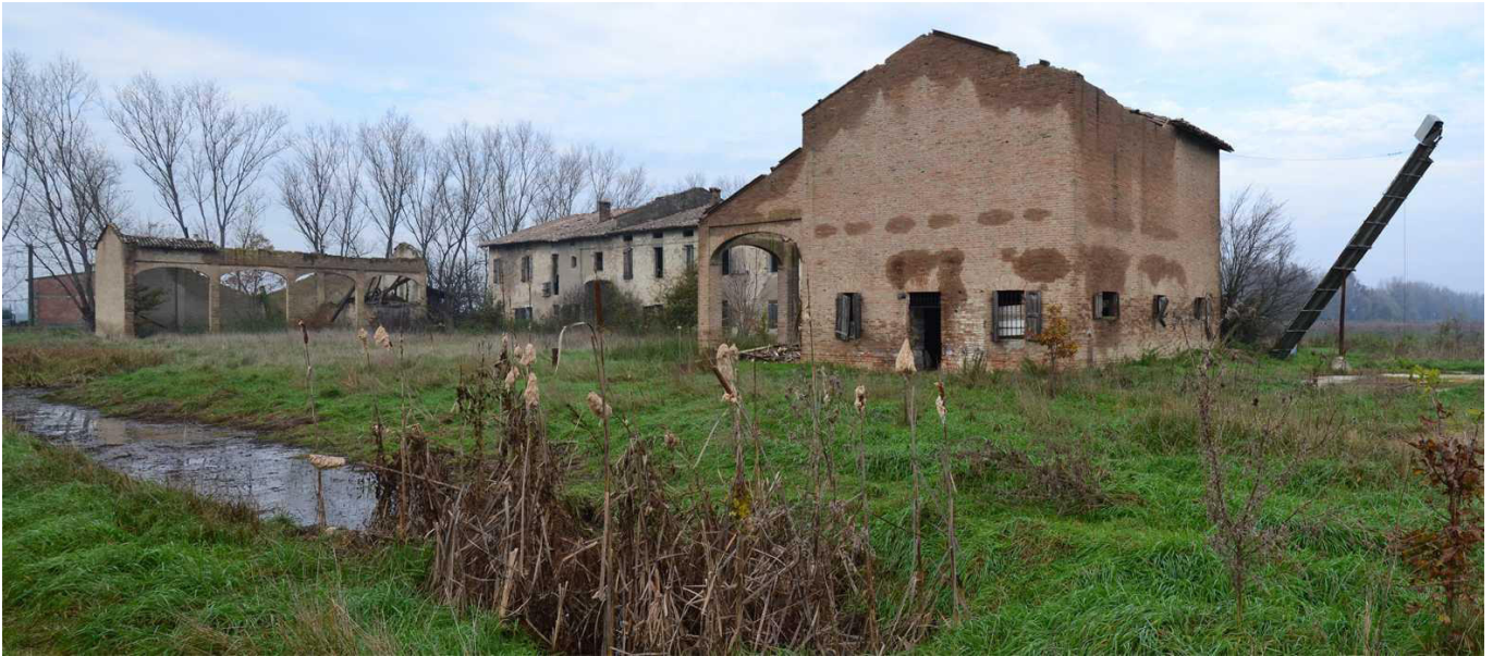
Figura 2.4 – Fabbricati rurali prossimi al Lotto 1a.
