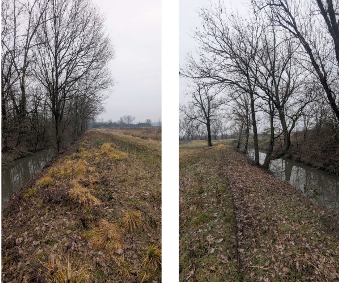
Figura 6.4.17: Panoramica del tratto in esame, con visuale da sud-ovest (foto a sx) e da nord-est (foto a dx).
