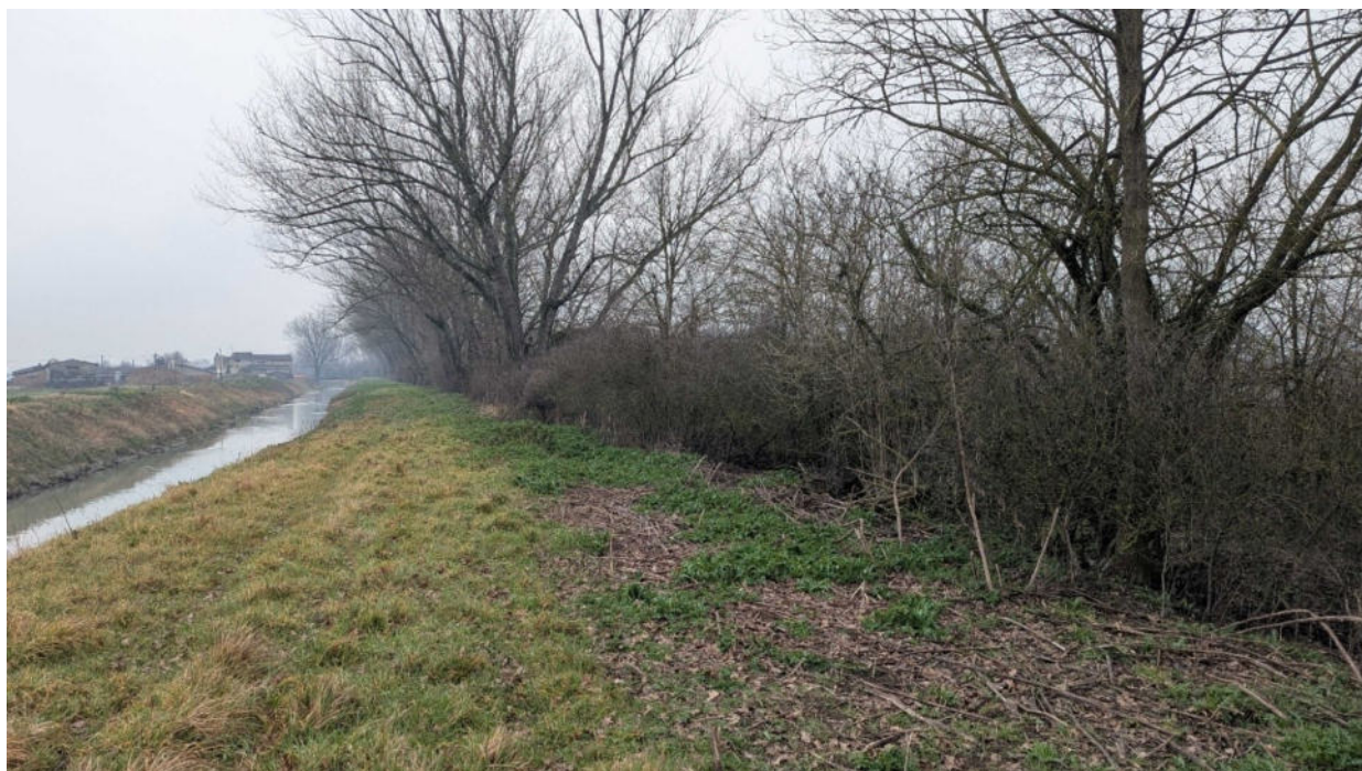
Figura 6.4.5: Panoramica della parte più a valle del tratto in esame, con visuale da nord; in questo settore il filare di pioppi sulla scarpata esterna è in parte sostituito da altre specie arboree (farnia) e da macchie arbustive di sanguinello e prugnolo.
