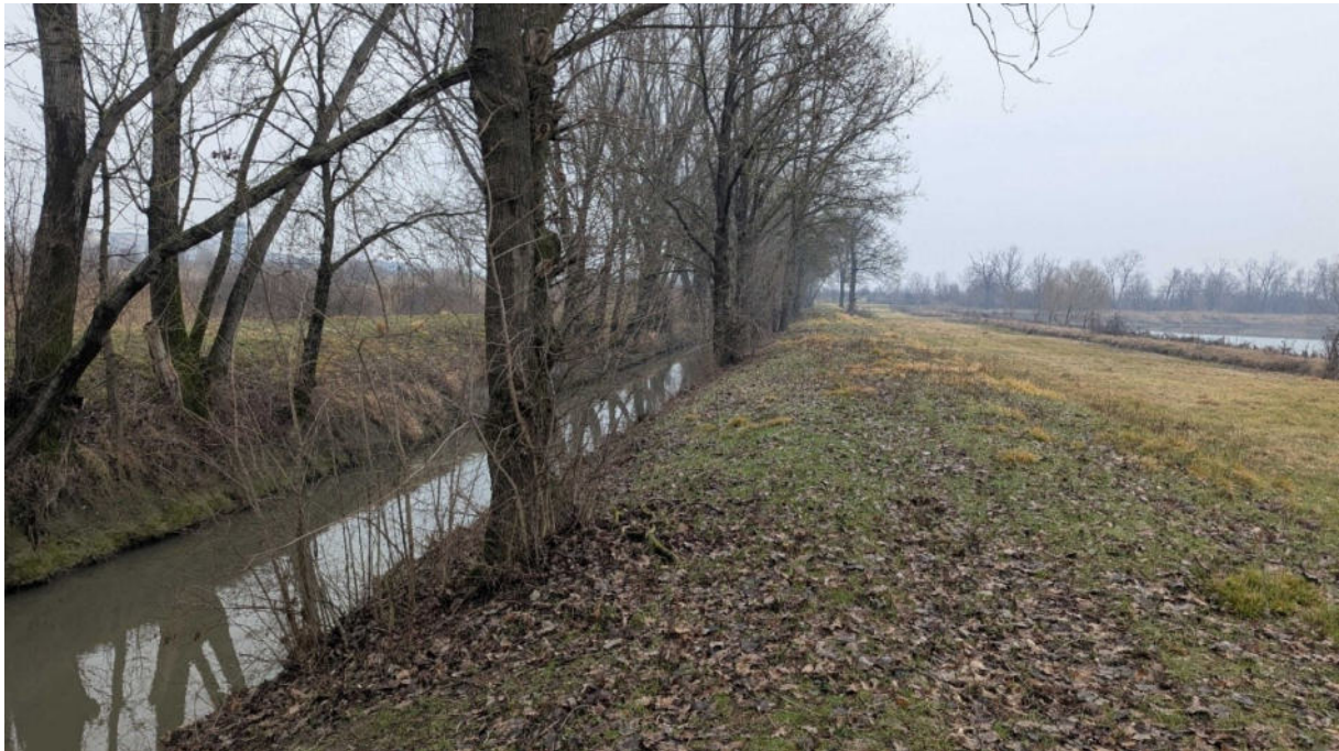
Figura 6.4.13: Panoramica del tratto in esame, con visuale da sud; gli esemplari arborei risultano ubicati sulla scarpata interna dell'argine del Lorno.
