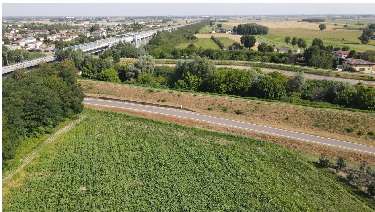
Figura 17: Foto Drone (118) – Vista dell'intersezione tra il Fiume Panaro e il viadotto ferroviario.
