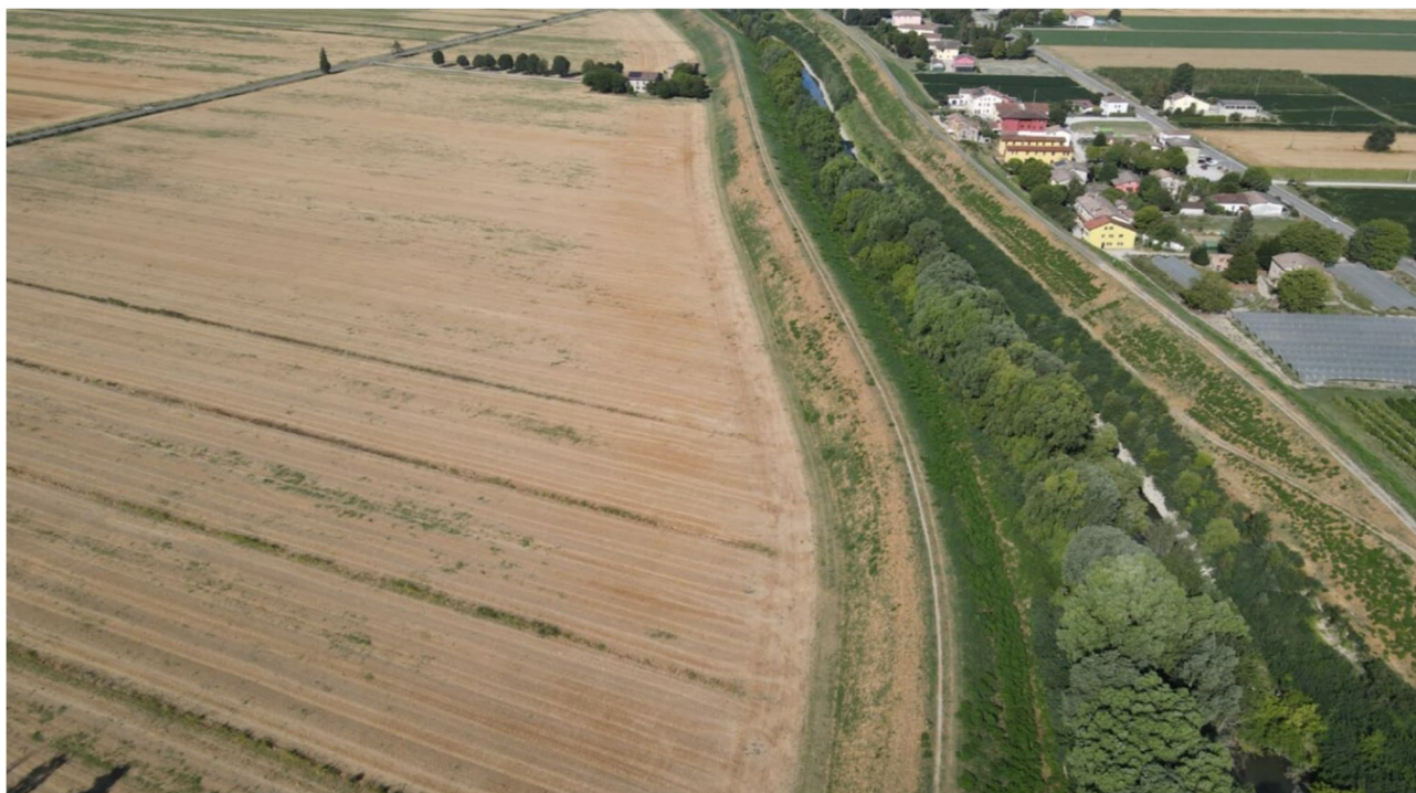
Figura 23 – Foto panoramiche su area di impianto. Si evidenzia la topografia pianeggiante.
