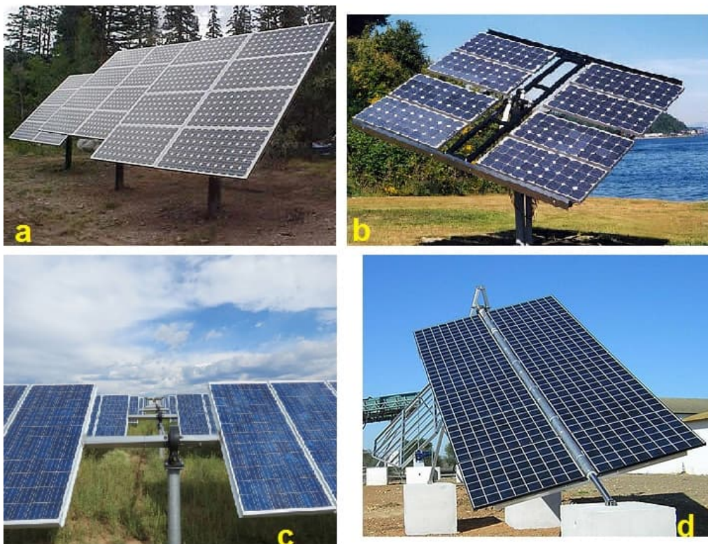
Figura 16 - Sistemi ad inseguimento: a) inseguitore di tilt, b) inseguitore di azimut, c) inseguitore di rollio, d) inseguitore ad asse polare.
