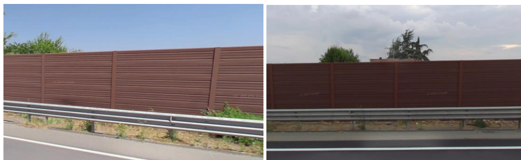
Esempi di barriere acustiche esistenti
