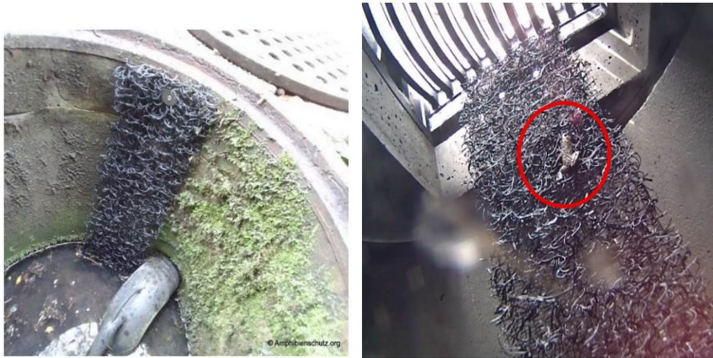
Figura 6-14 – Esempi di sistemi di fuga per evitare che animali di piccola taglia restino intrappolati nei pozzetti di scolo.
