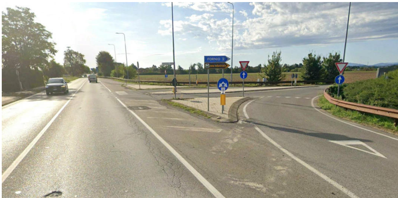
Figura 10.2.2 – Intersezione tra la Via Emilia e la strada comunale per Fornio a destra (ripresa in direzione del centro abitato di Fidenza, provenendo da ovest).
