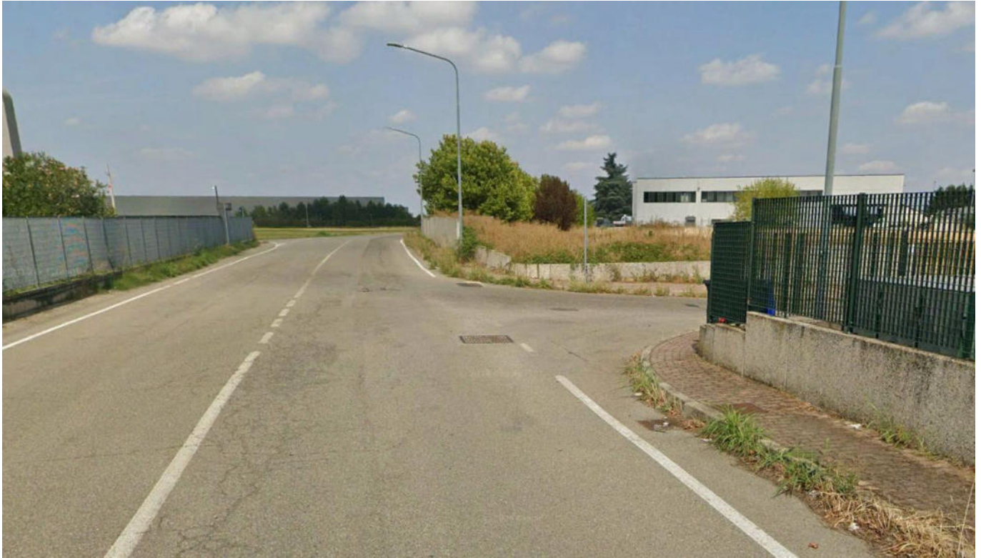
Figura 10.2.4 – Intersezione tra la strada comunale per Fornio e via della Fonderia a destra (ripresa in direzione nord verso la Via Emilia).
