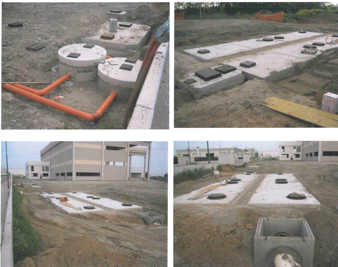
Figura 3.2.5 – Documentazione fotografica della posa del sistema di trattamento delle acque meteoriche (tratta da “Relazione tecnica relativa all’impianto trattamento acque prima pioggia della ditta Fidenza 2000/Valparma Rottami Srl” ad opera dell’Ing. Gian Franco Uni).
