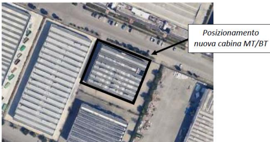
Figura 36 Posizionamento della cabina MT
