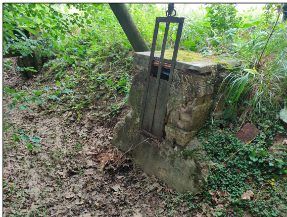
FIGURA 3-4 PARATOIA NEL TRATTO E.A DELLA CANALINA DI VIGNALE
