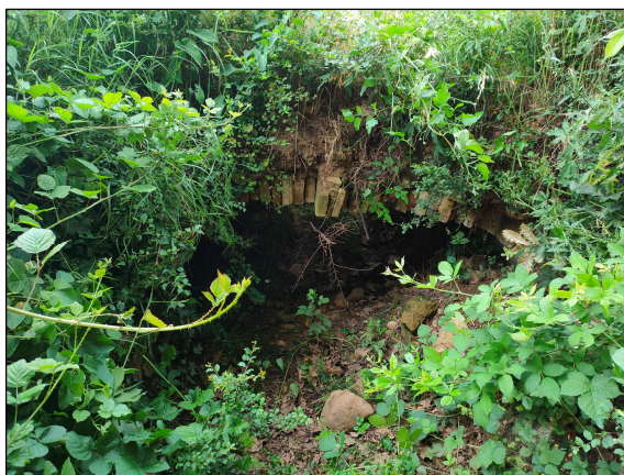
FIGURA 3-6 PONTICELLO NEL TRATTO F DELLA CANALINA DI VIGNALE
