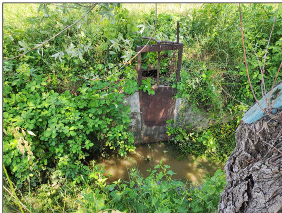
FIGURA 3-5 PARATOIA NEL TRATTO E.A DELLA CANALINA DI VIGNALE
