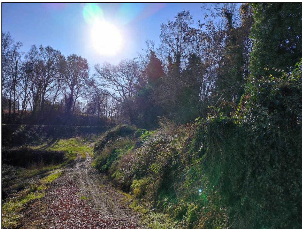
FIGURA 4-25 CANALINA DI VIGNALE NEL TRATTO F
