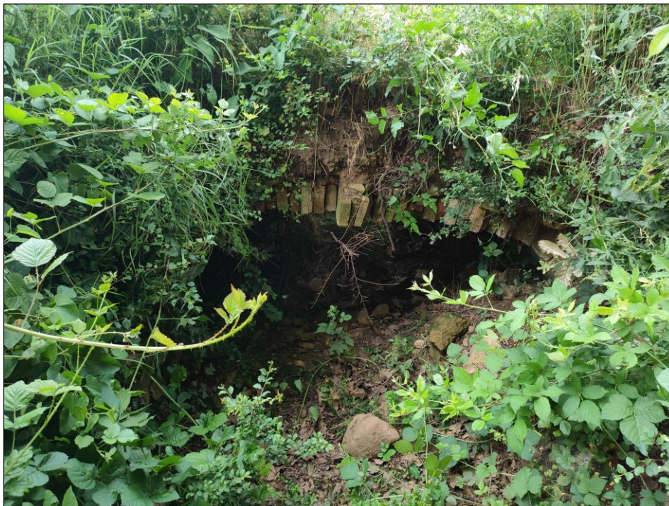
FIGURA 4-28 PONTICELLO NEL TRATTO F DELLA CANALINA DI VIGNALE
