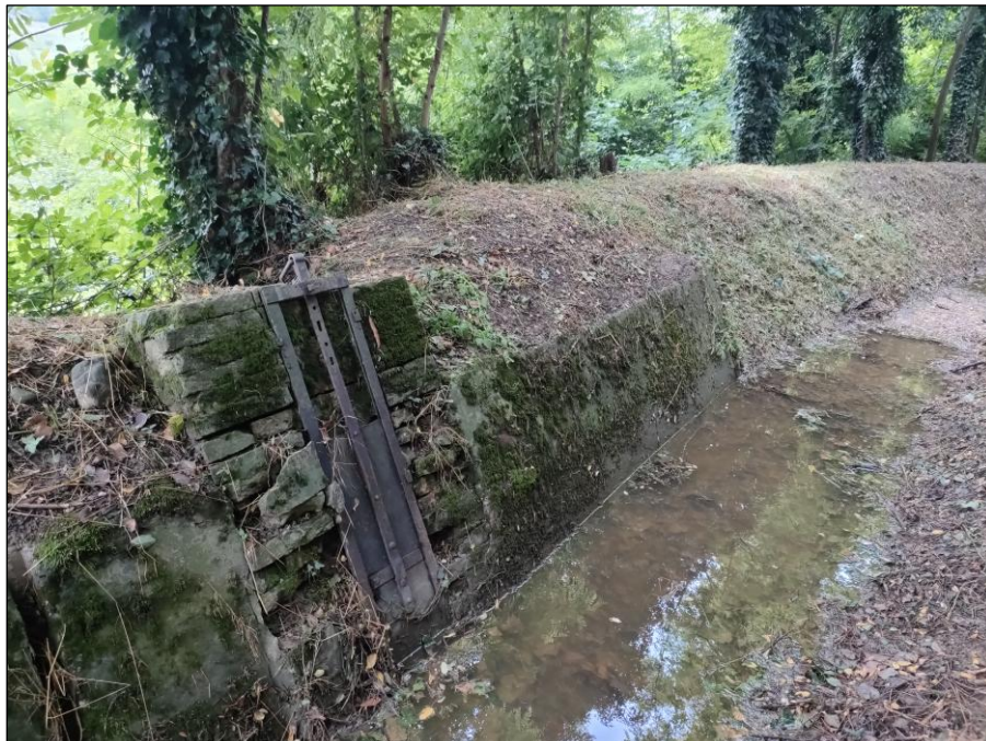
FIGURA 4-24 CANALINA DI VIGNALE NEL TRATTO E.A
