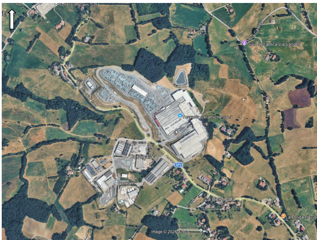
Figura 1.1 – Inquadramento dell'area oggetto di studio
