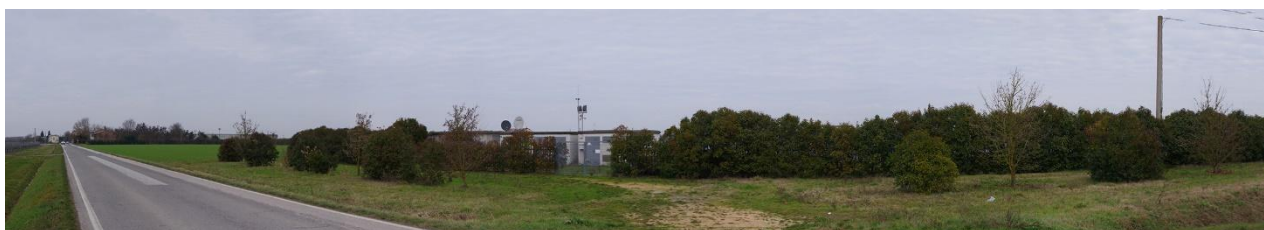
Figura 6-11 Impianto fotovoltaico (schermato) lungo via Puntiroli, a est di Conselice
