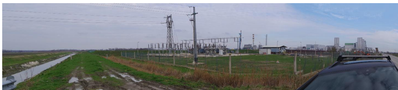
Figura 6-10 Stabilimento Unigrà e infrastrutture energetiche
