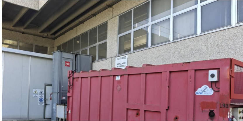
Foto 5 – stoccaggio dei rifiuti plastici all'esterno in zona coperta ed impermeabilizzata
