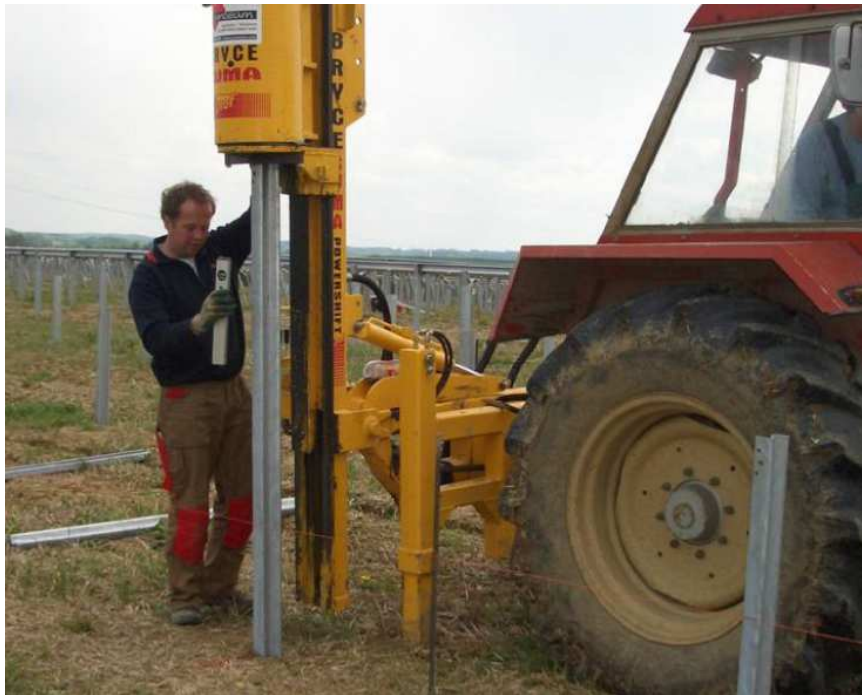
Foto n°2: Particolare delle fasi di infissione dei pali di fondazione dei pannelli fotovoltaici
