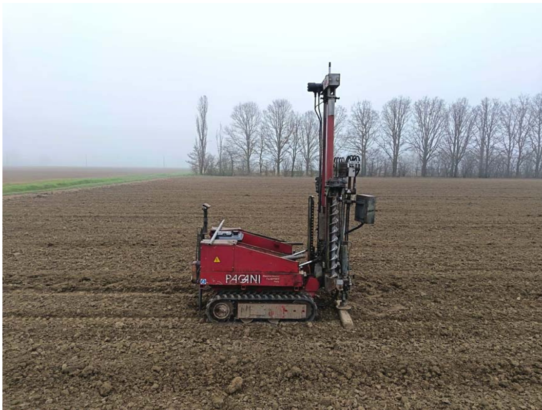
Foto n°2: Fasi dell'esecuzione della prova CPT2
