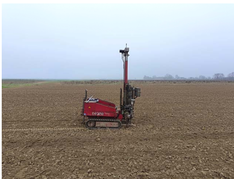
Foto n°5: Particolare delle fasi di realizzazione della prova CPT3
