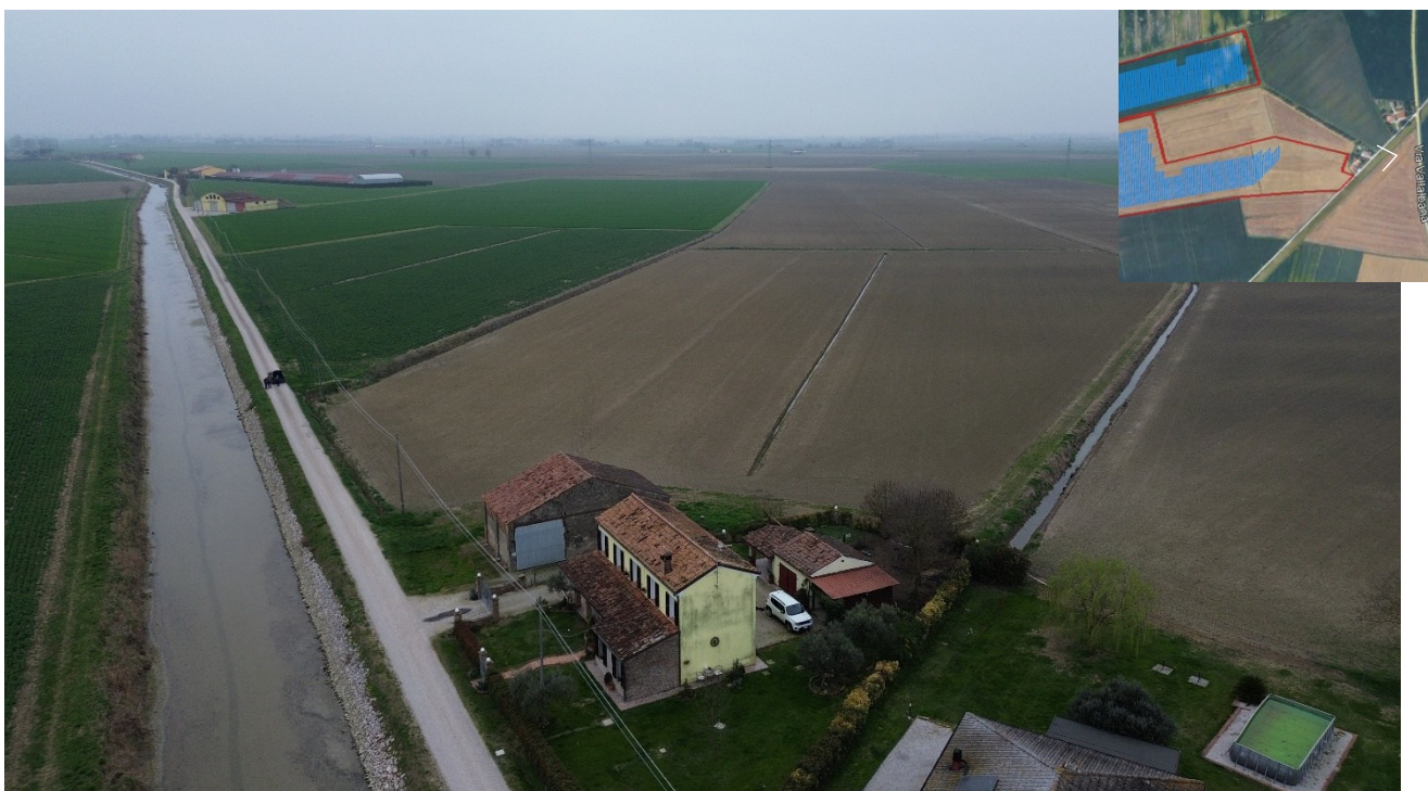
Figura 41: Stato attuale - lato sud-est
