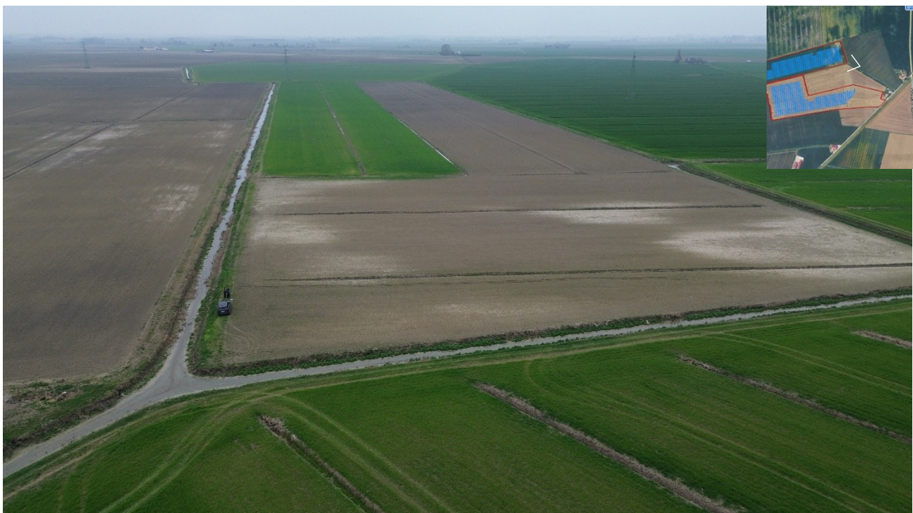
Figura 39: Stato attuale - lato est
