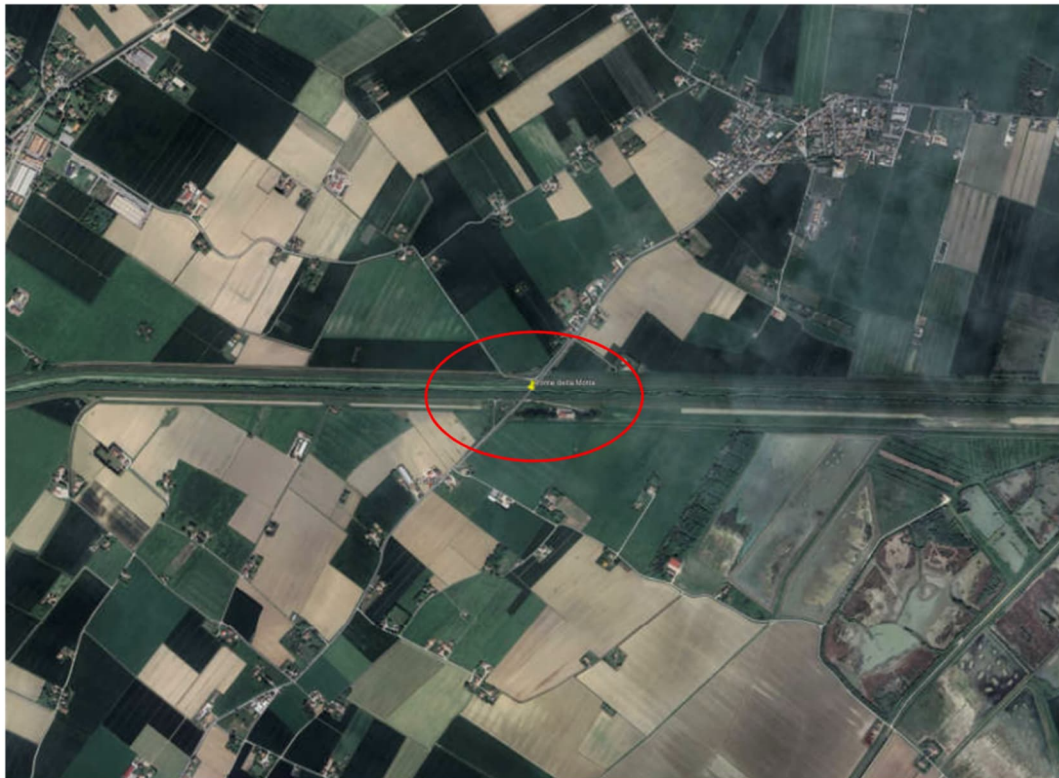
Figura 3-1: Inquadramento dell'area di intervento prima del crollo
