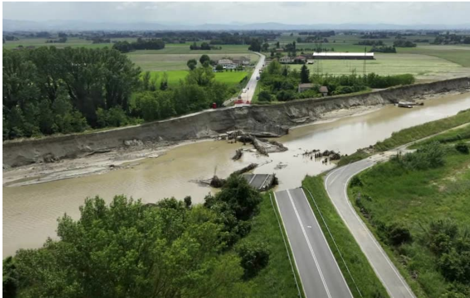
Figura 1-3: Vista dell'attraversamento a seguito del crollo (16/17 maggio 2023)
