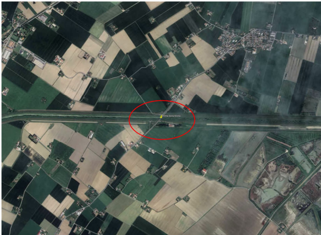
Figura 1-1: Inquadramento dell'area di intervento prima del crollo
