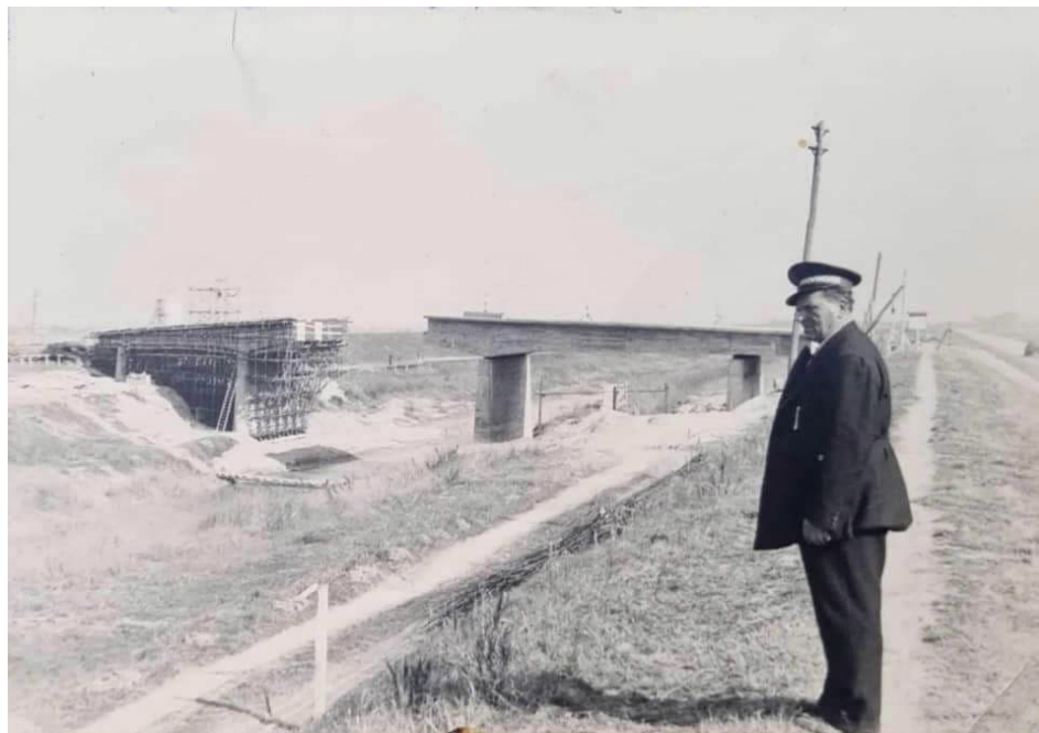
Figura 1-2: Fasi costruttive del ponte crollato (1958)
