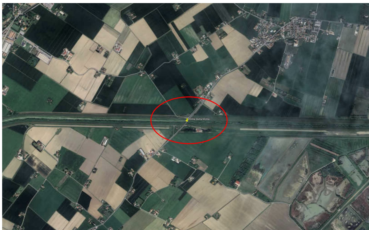
Figura 1 –Inquadramento dell'area di intervento prima del crollo
