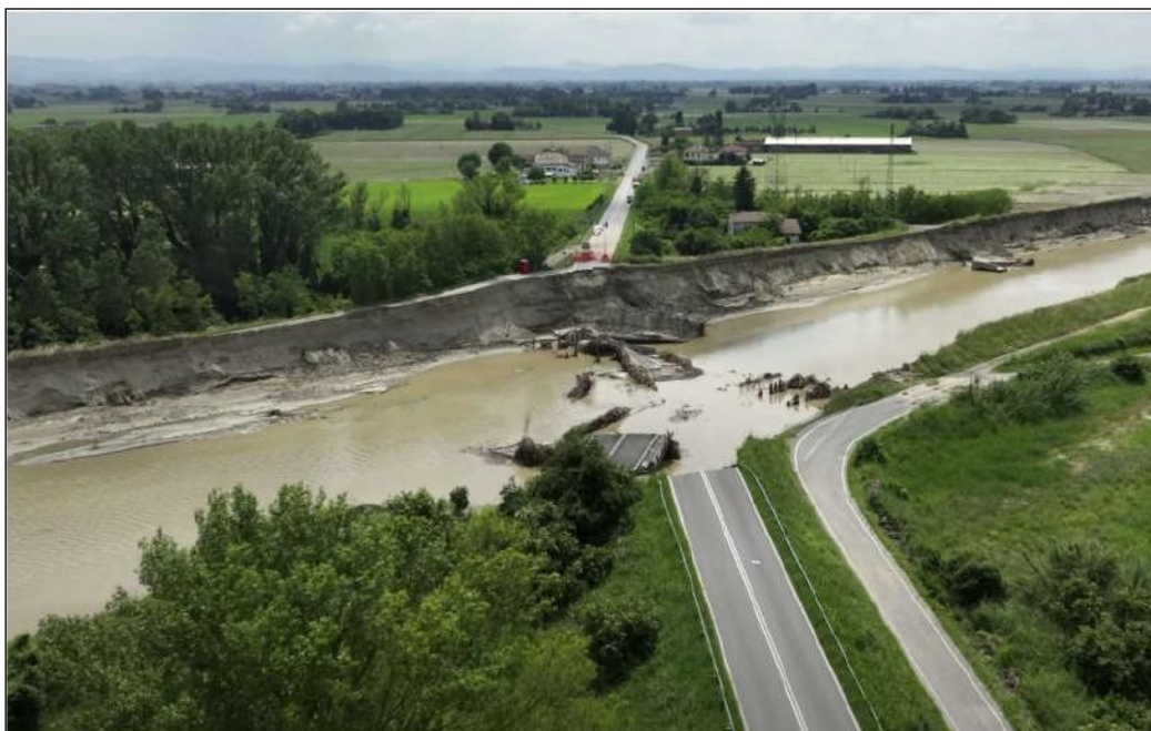
Figura 2 Vista dell'attraversamento a seguito del crollo (16/17 maggio 2023)
