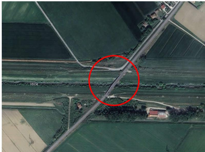
Figura 1-1: Corografia di inquadramento, vista del ponte prima del crollo a seguito della piena del 16/17 maggio 2023
