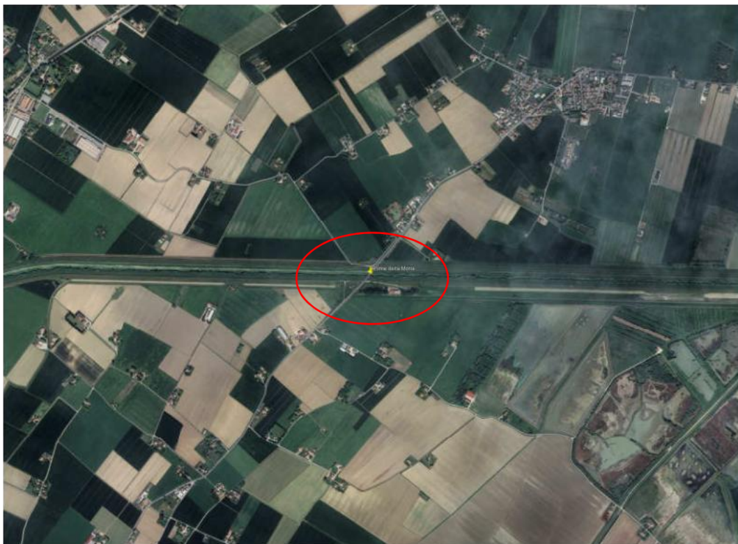
Figure 1. Inquadramento dell'area di intervento prima del crollo
