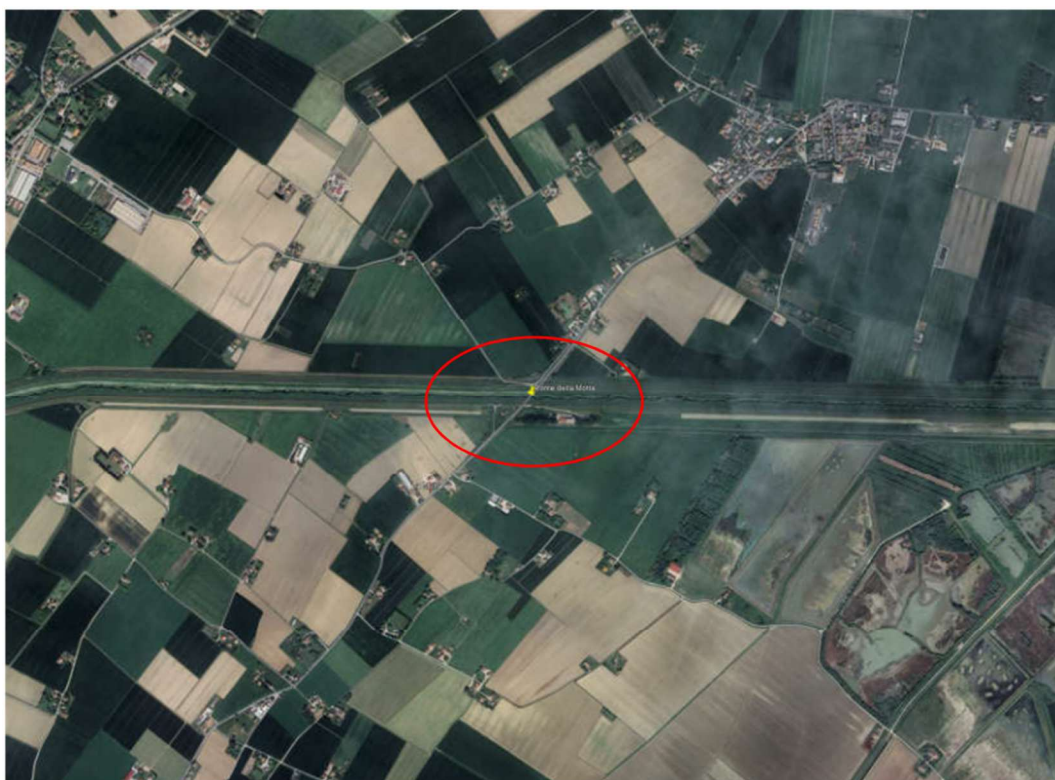
Figure 1. Inquadramento dell'area di intervento prima del crollo
