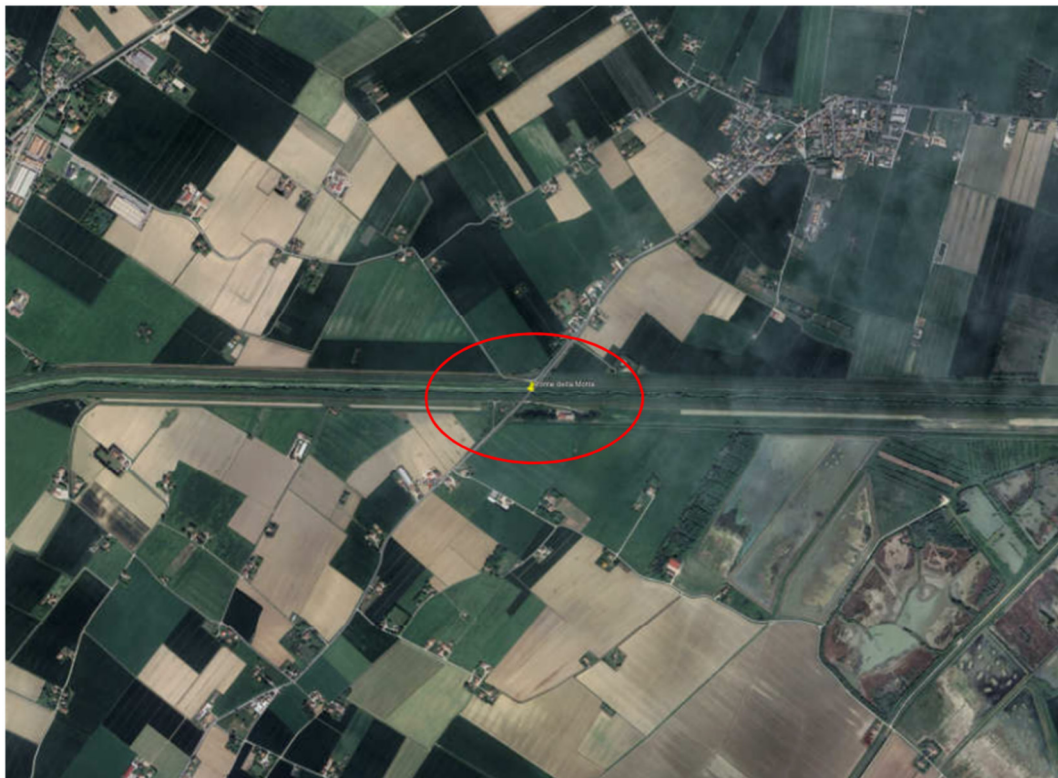
Figure 1. Inquadramento dell’area di intervento prima del crollo
