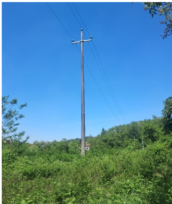
Figura A.8 – Vista dal punto di ripresa n. 9. Uno dei pali della linea elettrica in media tensione da spostare.
