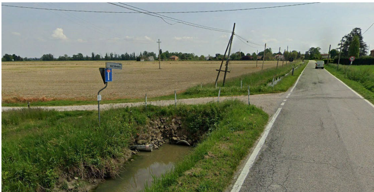
Figura 4-8: Strada di accesso per l'area di progetto da Via Sgarbata
