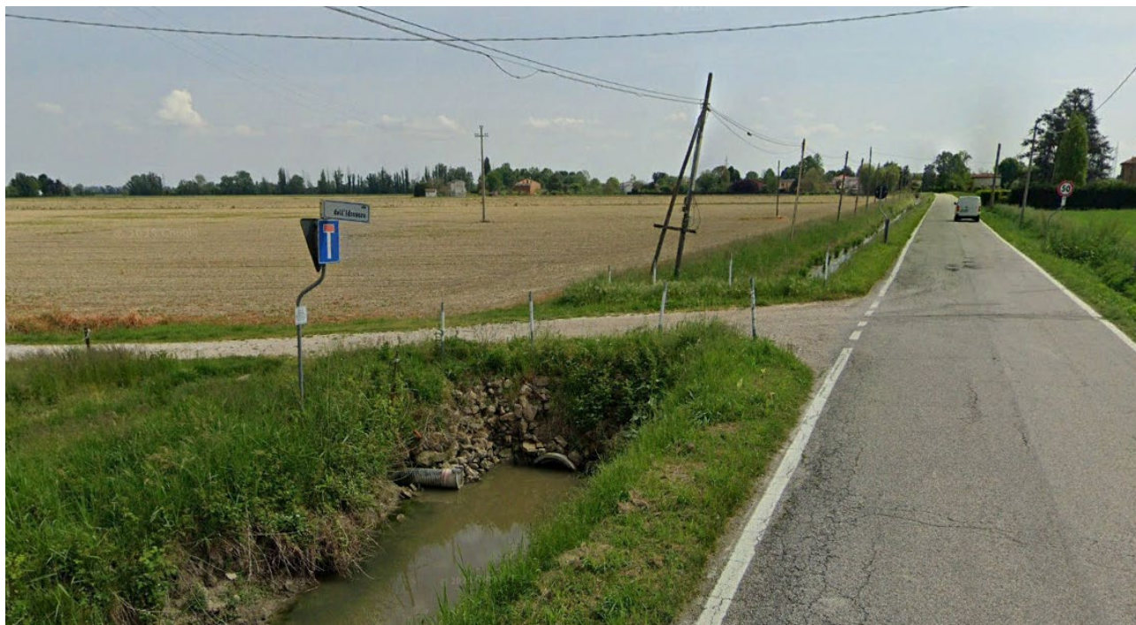
Figura 2-7: Strada di accesso per l'area di progetto da Via Sgarbata
