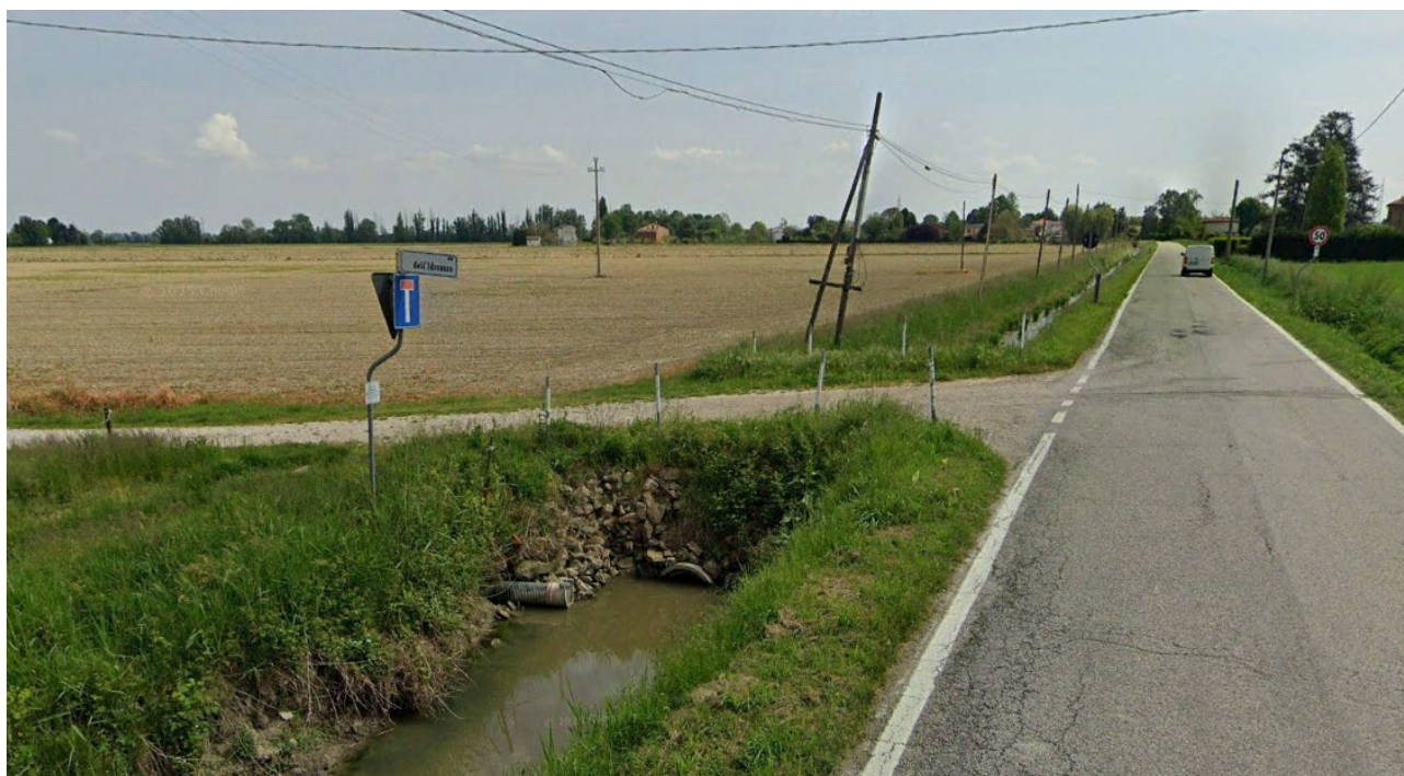
Figura 3-5: Strada di accesso per l'area di progetto da Via Sgarbata
