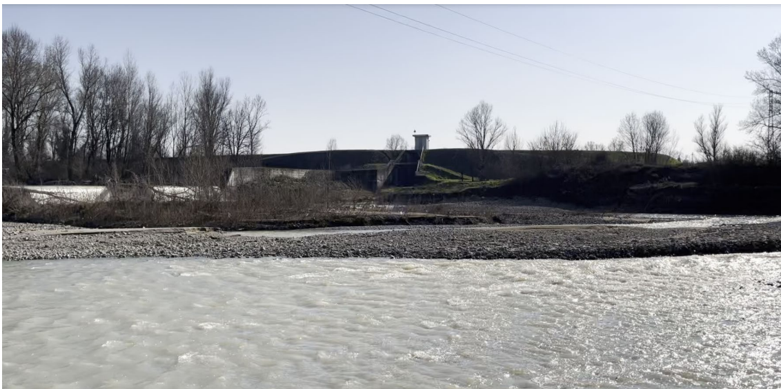
Figura 42 - Ripresa del manufatto di scarico della cassa di espansione (Foto da Sopralluogo effettuato in data 06/03/2025).
