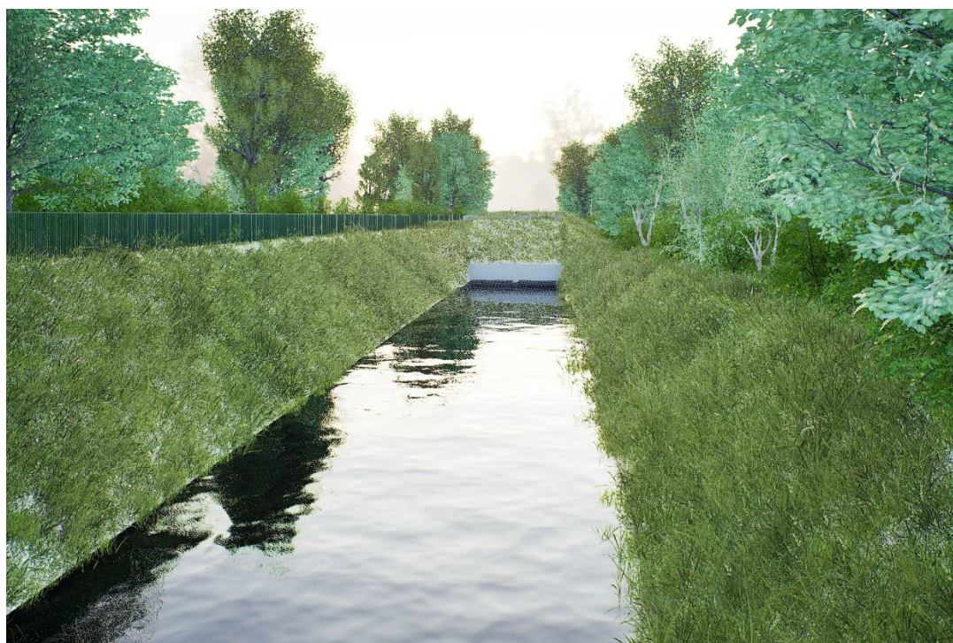
Figura 52 – Vista dal Canale di Derivazione
