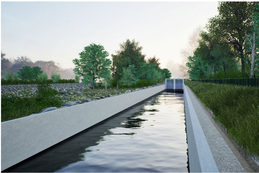
Figura 53 - Vista dal Canale di Scarico
