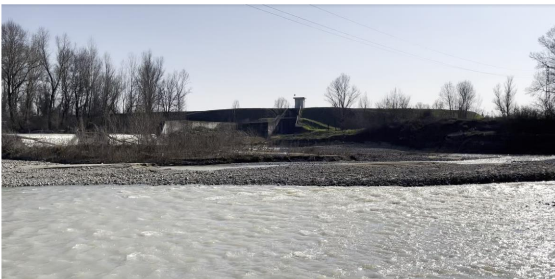
Figura 4 - Ripresa del manufatto di scarico della cassa di espansione (Foto da Sopralluogo effettuato in data 06/03/2025).
