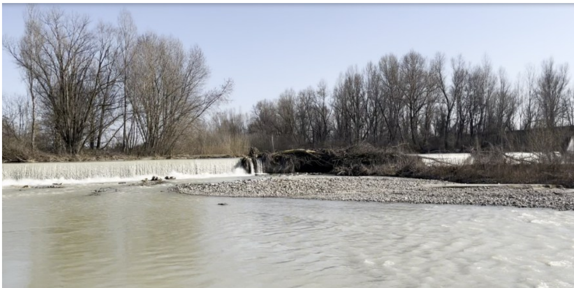
Figura 2 - Nell'immagine è visibile la briglia esistente sul Torrente Enza (Foto da Sopralluogo effettuato in data 06/03/2025).
