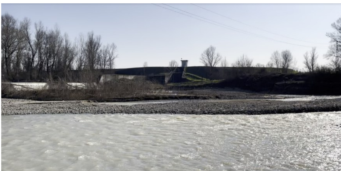
Figura 3 - Ripresa del manufatto di scarico della cassa di espansione (Foto da Sopralluogo effettuato in data 06/03/2025).
