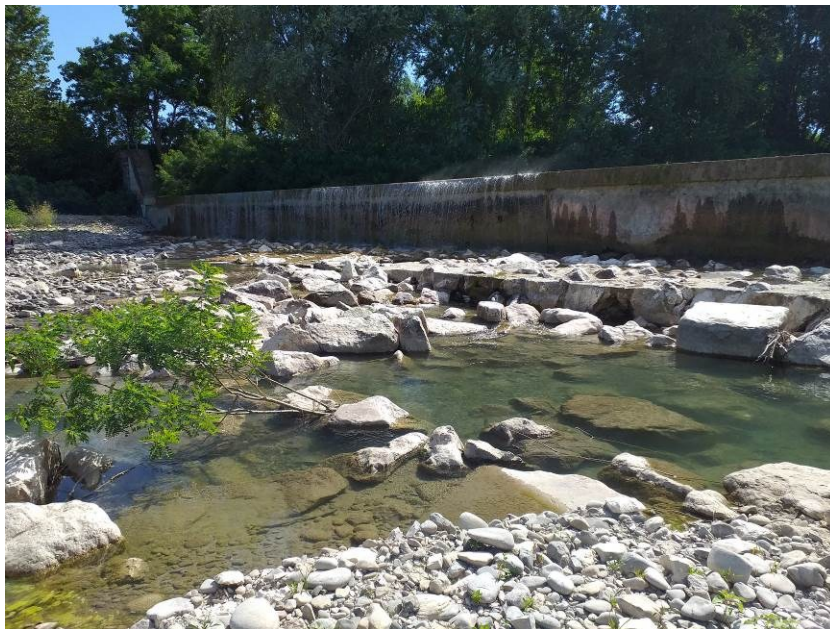
La briglia a valle del ponte nel punto di derivazione in sponda sinistra
