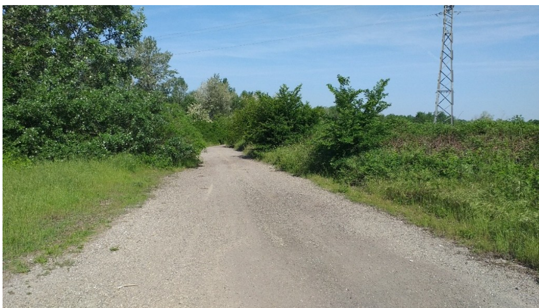
Figura 41: strada sterrata e terreno interessati da realizzazione cavidotto interrato
